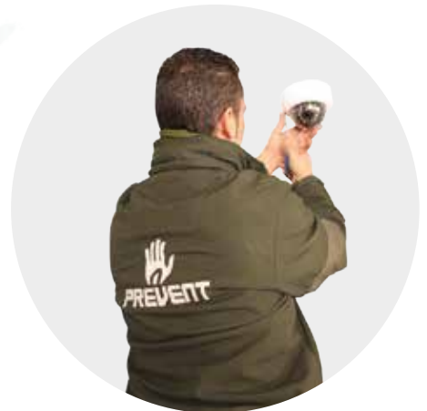
Personal propio con garantía de cumplimiento de la normativa de prevención de riesgos laborales.
