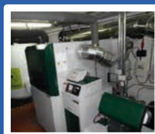
REFORMAS INTEGRALES DE SALAS DE CALDERAS DE EDIFICIOS
