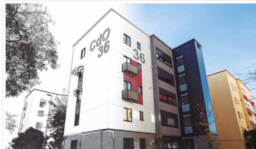
“OFRECEMOS TODOS LOS SERVICIOS NECESARIOS PARA LA CORRECTA RESTAURACIÓN DE UN EDIFICIO”
