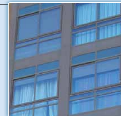
A la izda., fotografía de mirador con persiana por el exterior (incumpliendo normativa), y a la dcha. otro con persianas por el interior (cumpliendo normativa).
