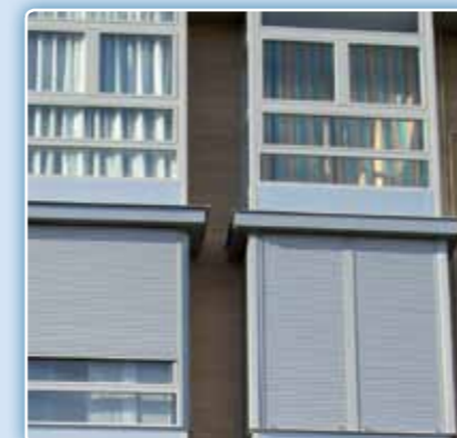
A la izda., fotografía de mirador con persiana por el exterior (incumpliendo normativa), y a la dcha. otro con persianas por el interior (cumpliendo normativa).
