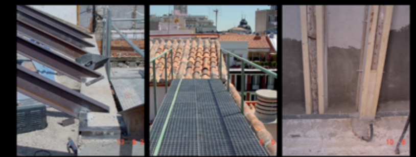
Renovación estructura Rehabilitación cubierta Refuerzo forjado
