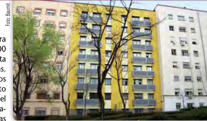
Ciudad de los Ángeles, c/ Manojos de Rosas. Edificio a la izquierda: Rehabilitación con monocapa (sin aislamiento). Edificio del centro: Rehabilitación con SATE. Edificio a la derecha sin rehabilitar.
