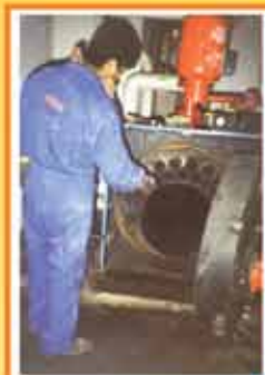
LIMPIEZA DE CALDERAS COMUNITARIAS DE GASOLEO
